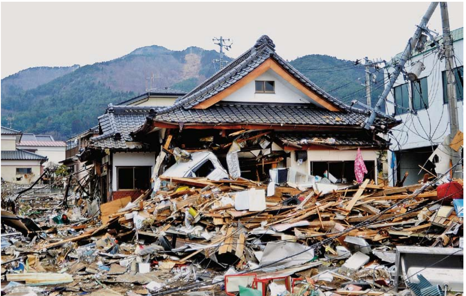
Bild der Zerstörung in Japan.
