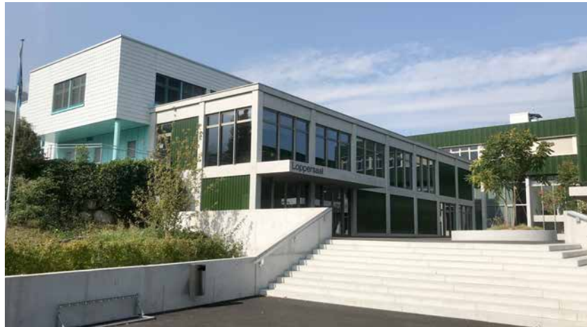
Loppersaal Hergiswil: Der grösste Saal Nidwaldens steht für die Konfirmation 2020 bereit.
